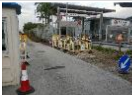
小灣車廠附近工地
