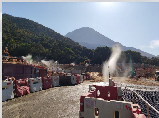
定時於工地進行灑水防止塵土飛揚
