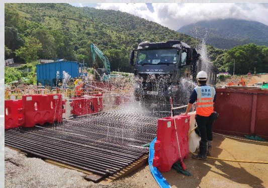
地盤出口設立洗車設施
