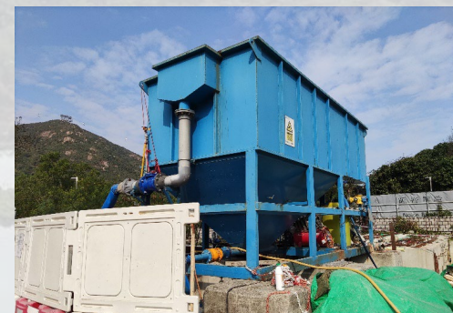
設置污水處理設施
