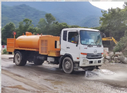
定時以水車灑水防止塵土飛揚
