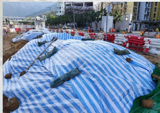
以帆布遮蓋建築物料防止塵土飛揚
