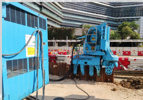
使用靜音設備進行鋼板樁移除工程
